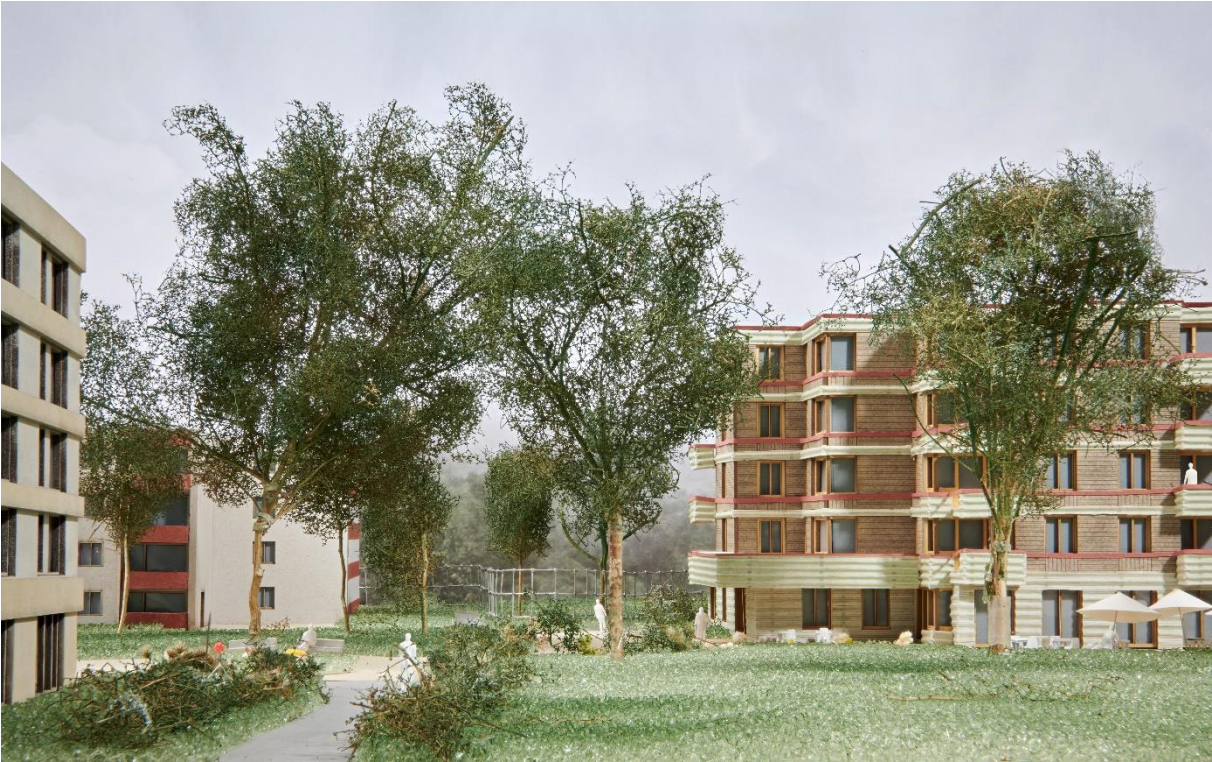
Blick auf das Gebäude von Nordwesten
